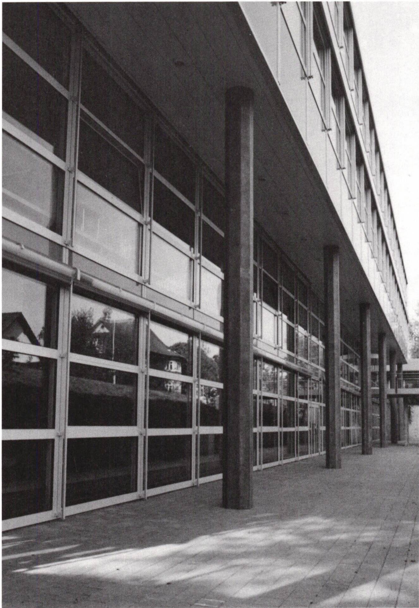
Die Glasfassade auf der Ostseite, zurückversetzt im Erd- und Untergeschoss: Die Umgebung spiegelt sich in der Fensterreihe der Mediothek. (Foto Ep)
