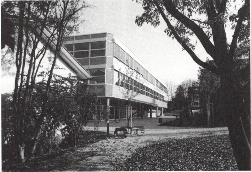
Vom Park aus ein Blick auf die Westfassade des Neubaus, der Platz davor dient im Sommer auch als «Gartenrestaurant» der Mensa. (Foto Ep)
