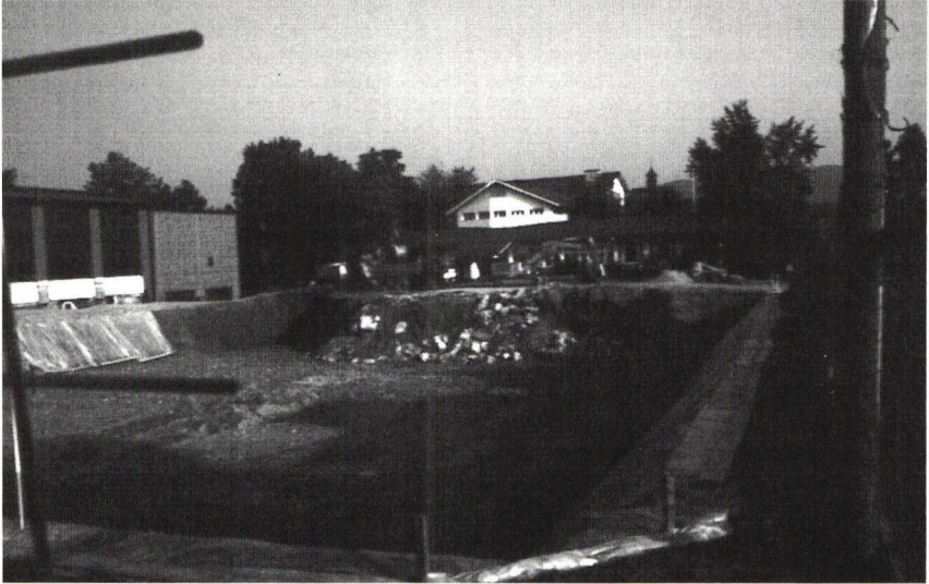
11. Juli: Die Baugrube kurz vor Vollendung des Aushubs, hinten erkennt man einen Teil des Altbaus, links die neue Doppelturnhalle aus dem Jahre 1981 (Foto: Ep).
