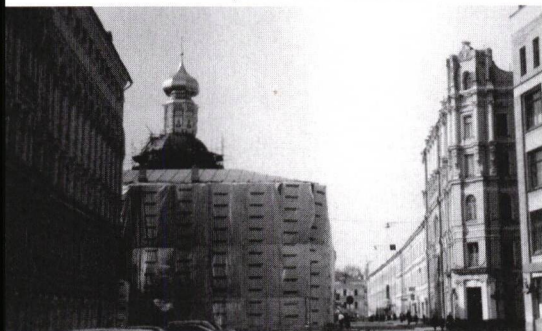
Moskau – eine Stadt im Umbruch – überall wird gebaut und renoviert.
