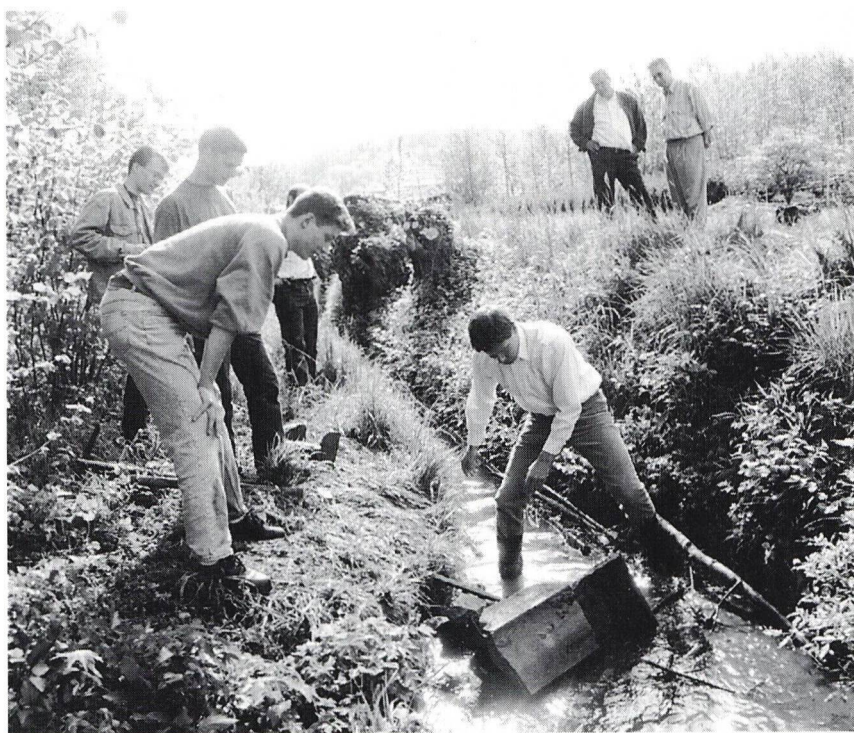
Handarbeit für die biologische Vielfalt des Aarauer Rombachs: Die mit dem Hammer zerschlagenen Betonschalen wurden aus dem Bachbett entfernt.
