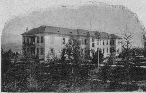
Mittelpavillon der kant. Krankenanstalt.
